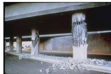
Flambement d'un pont © Esprit Génie Civil
