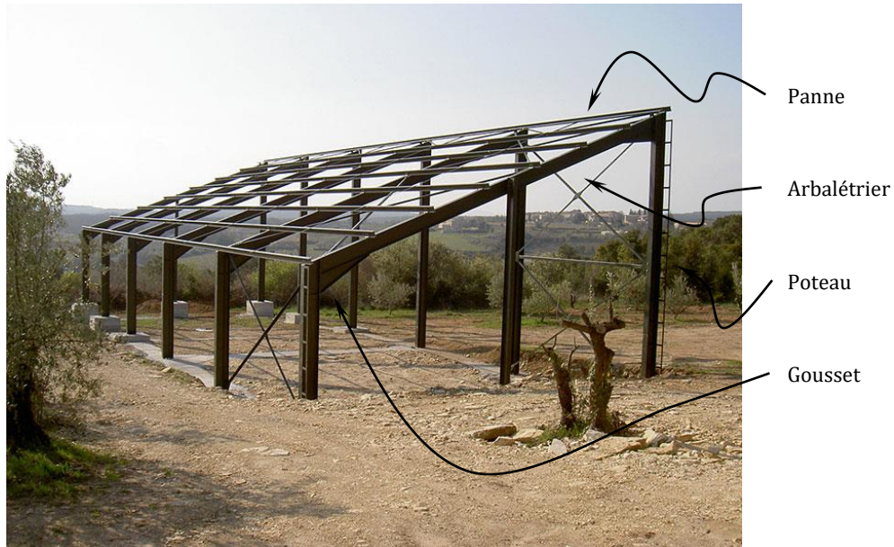
Figure N°1 : Vue d'une charpente métallique (source : http://marconnet-sarl.fr )
