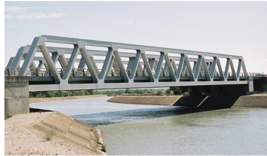
Figure N°1 : Vue d'un treillis de type Warren simple (source : Structurae)
